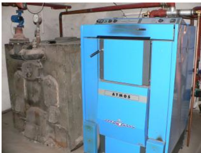
Obrázek 4: Výměna jednoho z kotlů v základní škole na Telčsku
