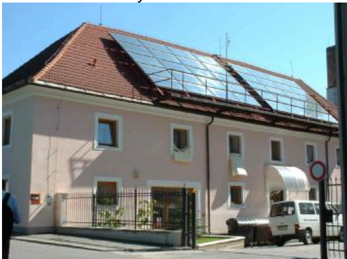
Obrázek 6: Solární systém na historické budově v Libníči.
