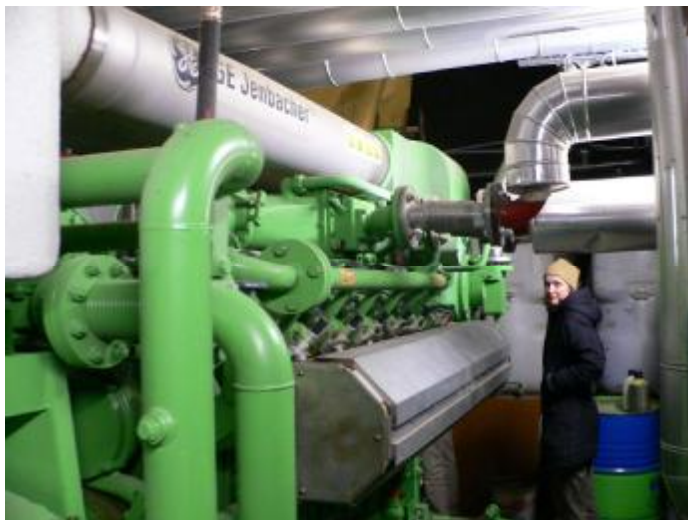
Obrázek 7: Pístový motor na bioplyn z kukuřice v Burgenlandu
